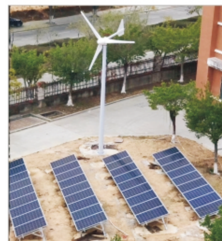
福建大学风光互补离变一体电站
